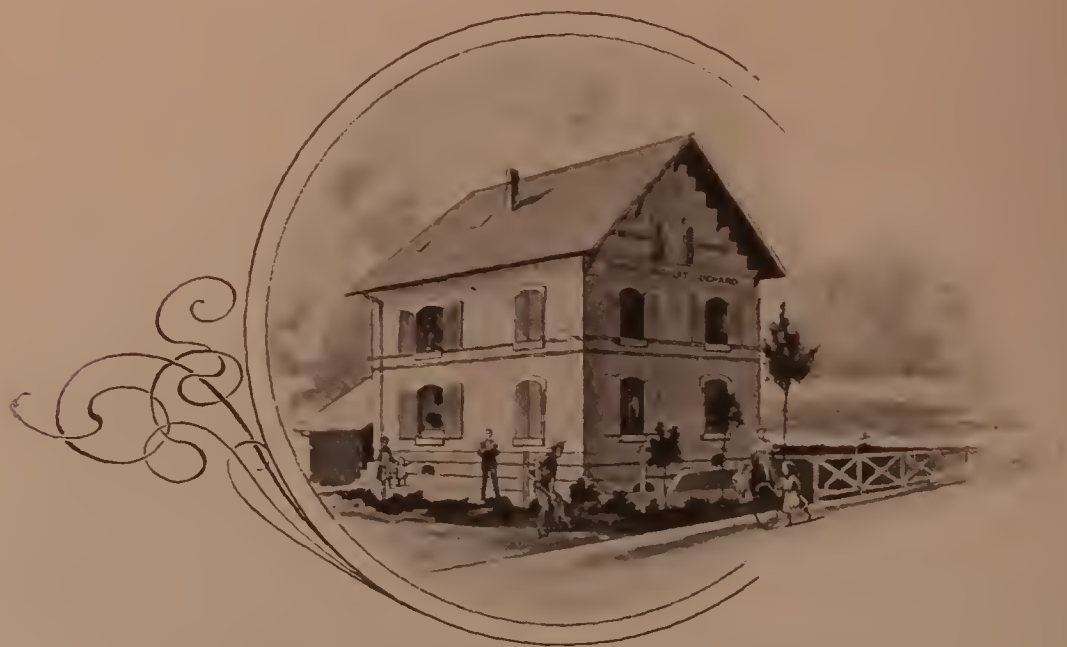
MAISON OUVRIÈRE DE LA FABRIQUE DE CHOCOLAT SUCHARD EXPOSÉE A VINCENNES.
